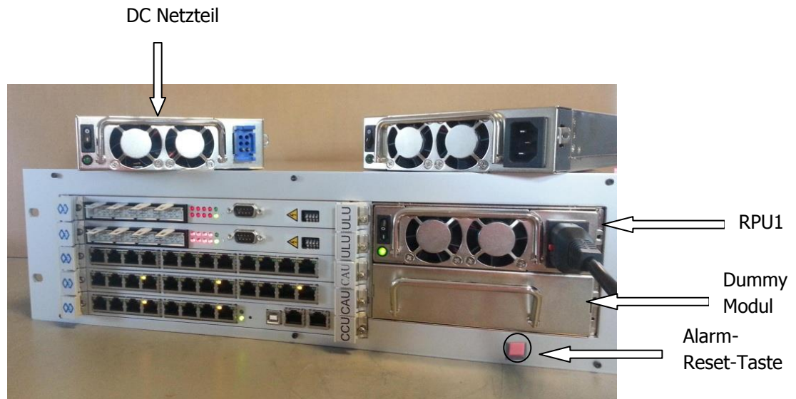
Abbildung 6: S7 bestückbar mit redundanzfähigen Netzteilen mit 230 Volt (AC) oder 48 Volt (DC) Primärversorgung. Hier abgebildet mit Dummy-Modul und Alarmtaster, bestückt mit CCU4, 2 CAU und 2 ULU.
